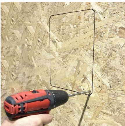
2. Просверлите отверстие.
